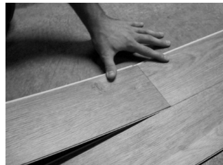
Figura 5. Incline el extremo de la tabla siguiente.
